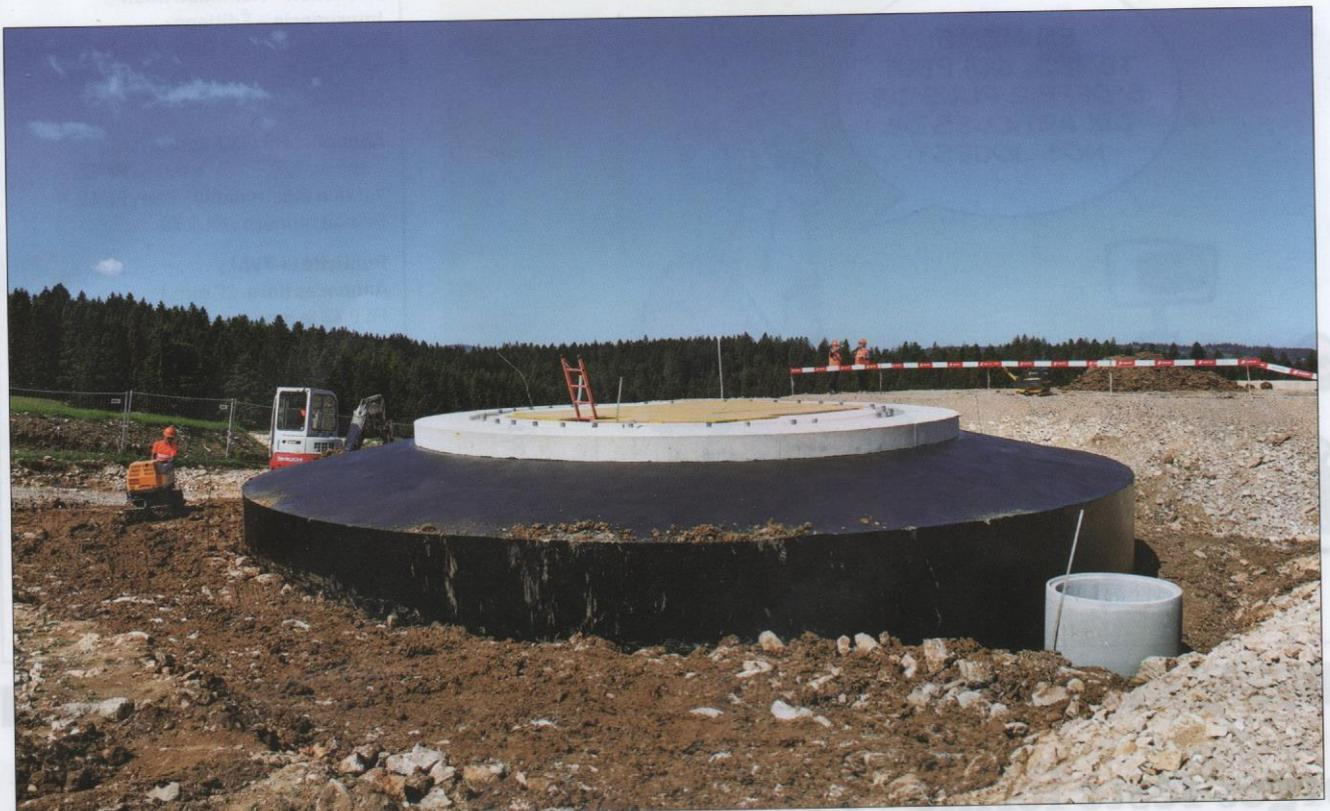
Les socles, une fois bétonnés, sont couverts d'un enduit hydrofuge. Ici le remblayage a débuté.
