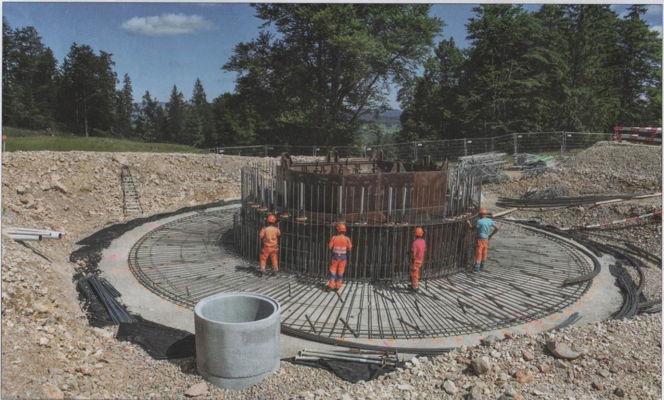
Les ouvriers s'affairent à poser la ferraille du socle de l'éolienne numéro 4, au Mont des Cerfs.
