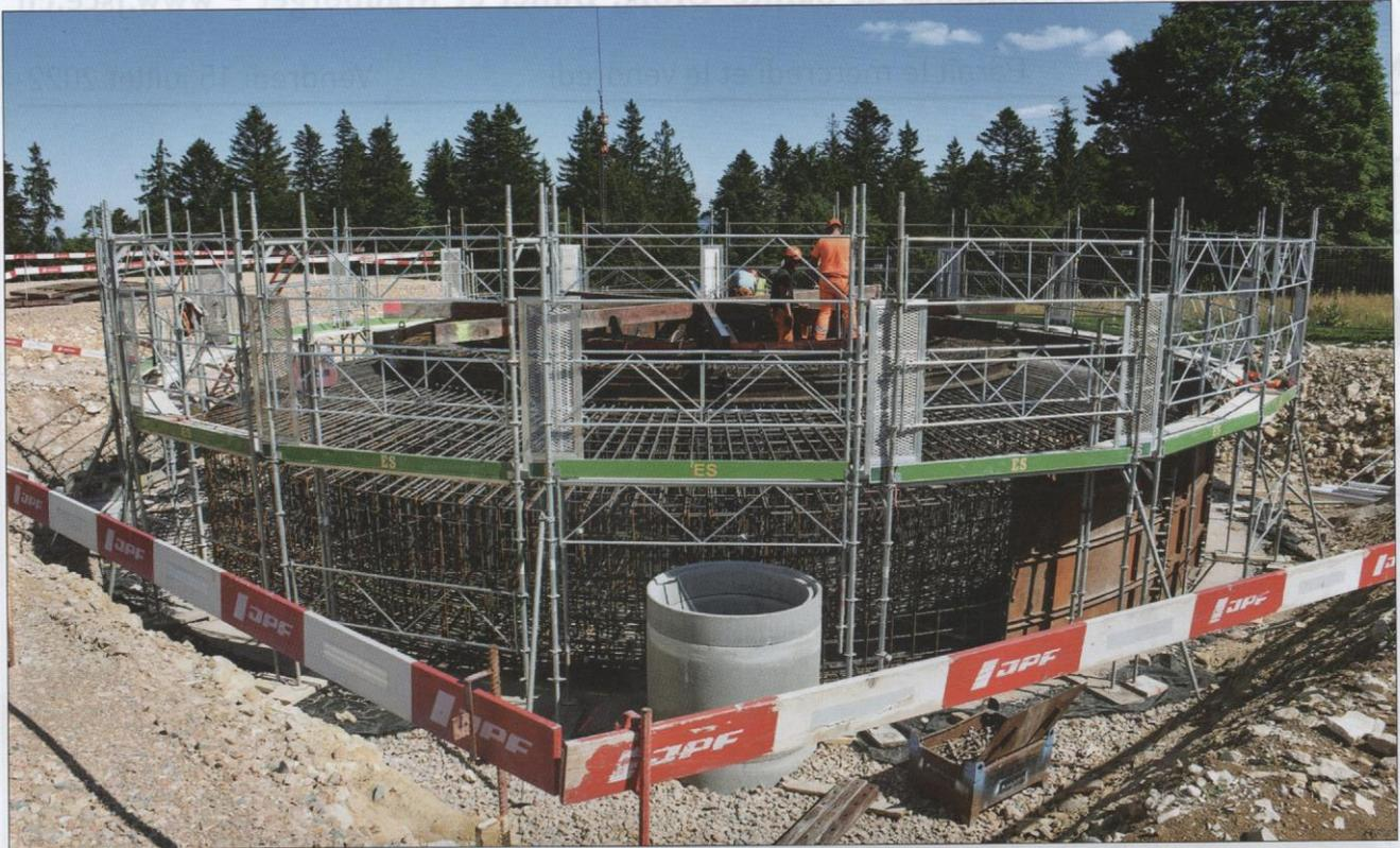
Le maillage des fers avant de recevoir les 350 m<sup>3</sup> de béton nécessaires par socle.
